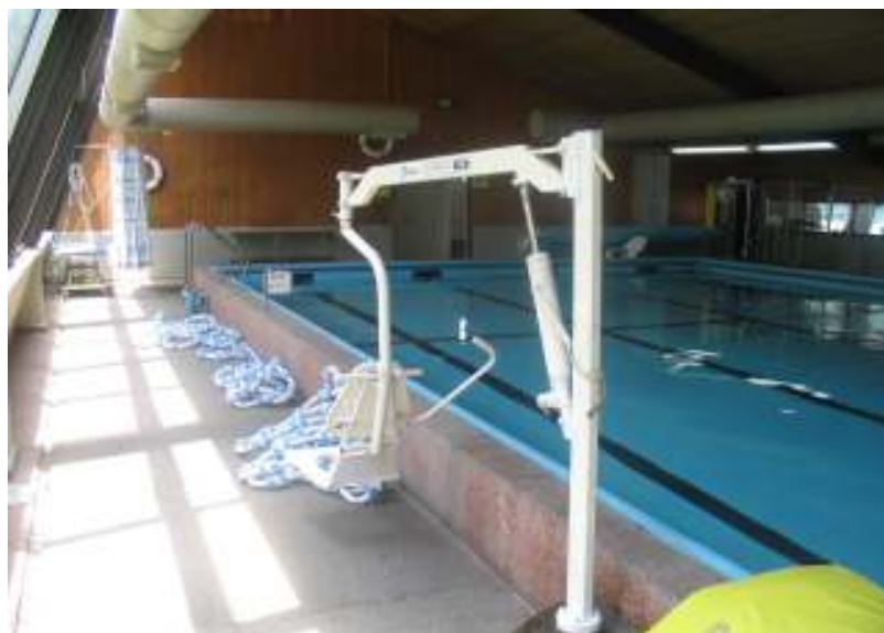
בריכה טיפולית איל"ן ר"ג (ספיבק) דפנות בריכה מוגבהות עם מנוף הידראולי (נתקבל סיוע של הקרן להקמה)
