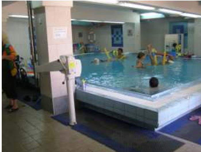
בריכה טיפולית בי"ח אלי"ן ירושלים – דפנות בריכה מוגבהות עם מנוף הידראולי (נתקבל סיוע של הקרן להקמה והצטיידות)
