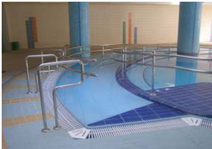
בריכה טיפולית בי"ח האון עיריית ת"א - כבש (רמפה) במים ומעקים סטנדרטיים (נתקבל סיוע של הקרן להקמה)
